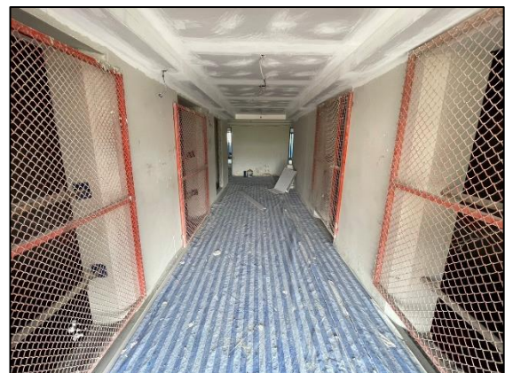
รูปที่ 2-49 ตะแกรงเหล็กป้องกันเศษวัสดุตกหล่น
