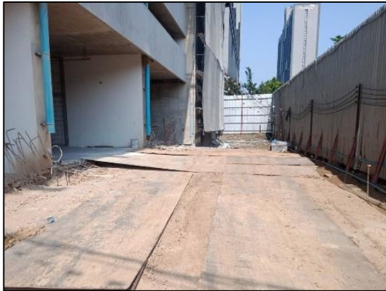
รูปที่ 2-17 แผ่นเหล็กปูพื้นบริเวณพื้นที่ก่อสร้าง
