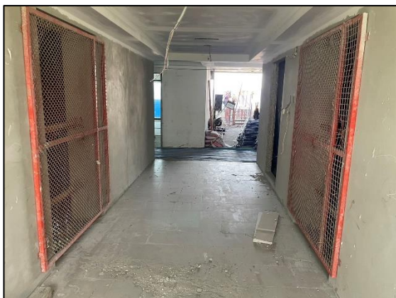
รูปที่ 2-49 ตะแกรงเหล็กป้องกันเศษวัสดุตกหล่น
