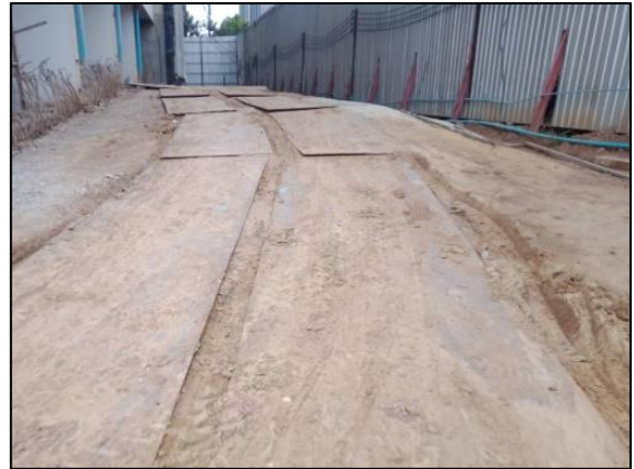
รูปที่ 2-17 แผ่นเหล็กปูพื้นบริเวณพื้นที่ก่อสร้าง
